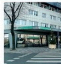
La sede Ausl di piazzale Milano
