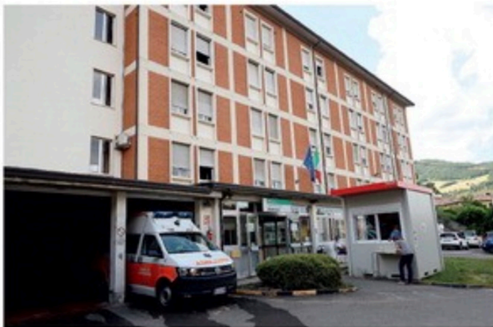
Lavori annunciati dal 2017: nuovo parcheggio, camera mortuaria, Tac e intervento antisismico
