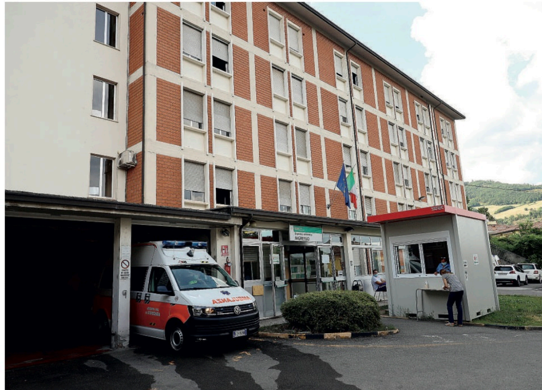
L'ospedale di Bobbio durante il cantiere non dovrà essere chiuso: i lavori erano attesi già dal 2017
