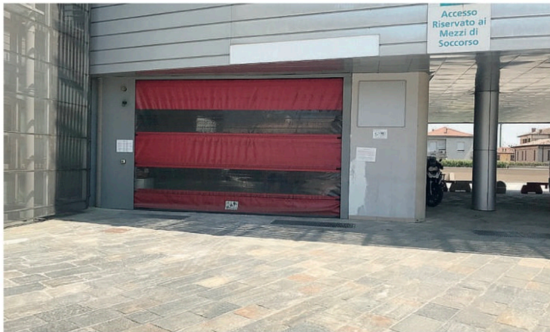
L'accesso del pronto soccorso di Fiorenzuola sbarrato dal marzo del 2020
