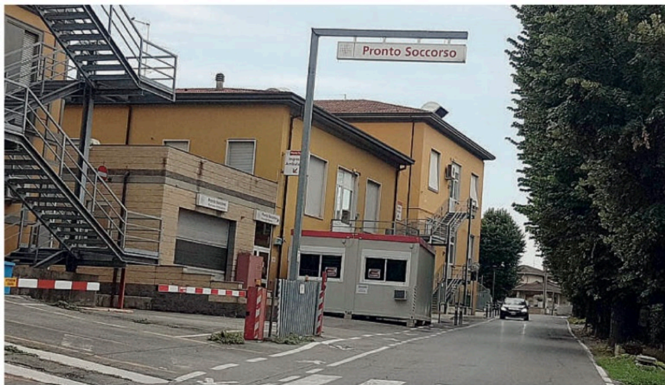
L'attuale Pronto soccorso: per realizzarne uno nuovo si attende lo sblocco di un finanziamento di 3 milioni FOTO BERSANI
