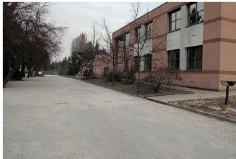
Uno degli edifici del polo scolastico Volta di Castelsangiovanni
