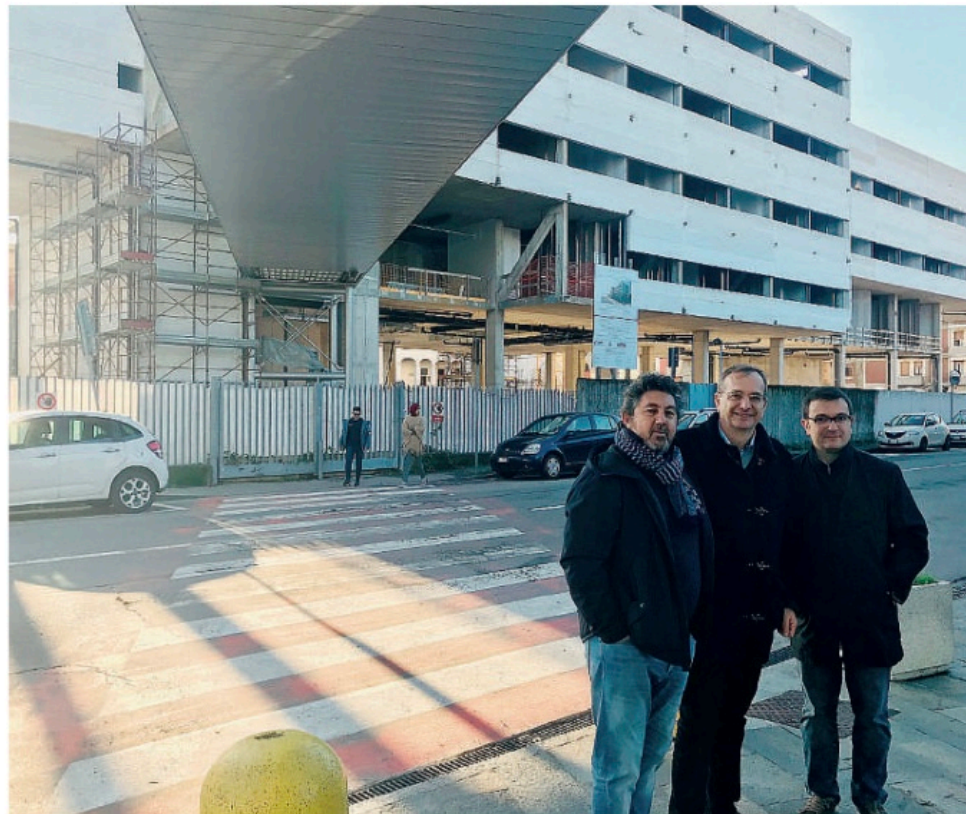
Il sindaco Gandolfi (al centro) con il consigliere Isola e l'assessore Minari davanti al cantiere dell'ospedale
