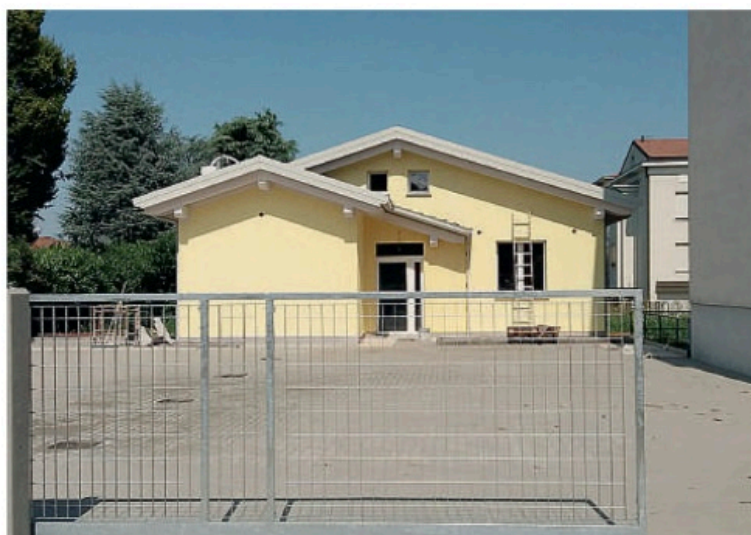
Si stanno ultimando i lavori in via Leopardi FOTO LUNARDINI
