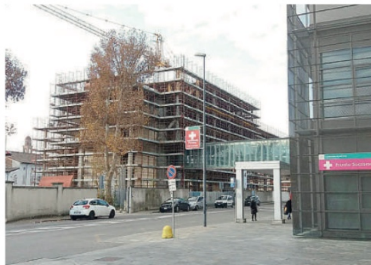
L'ospedale di Fiorenzuola e il cantiere del blocco B FOTO MENEGHELLI
