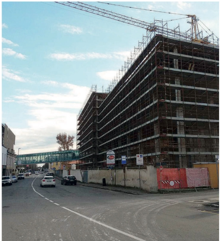
Il cantiere del blocco B dell'ospedale di Fiorenzuola FOTO MENEGHELLI
