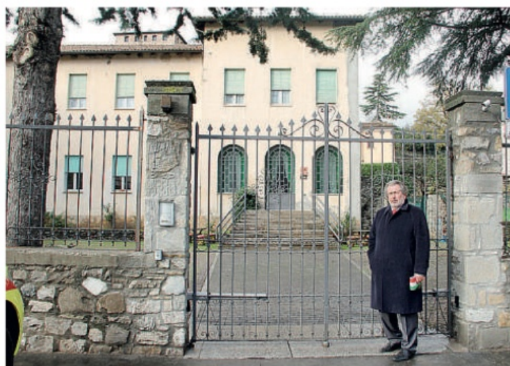
La struttura delle Gianelline; qui sarà realizzato l’appartamento per disabili
