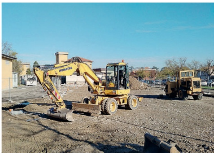
I lavori per realizzare 40 posti auto a lato di viale Due Giugno
