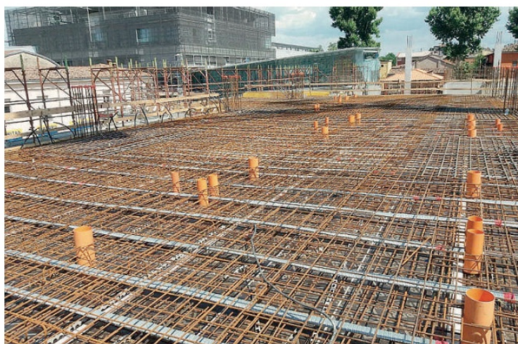
Il cantiere dell'ospedale di Fiorenzuola. È iniziata la costruzione del terzo piano del blocco B
