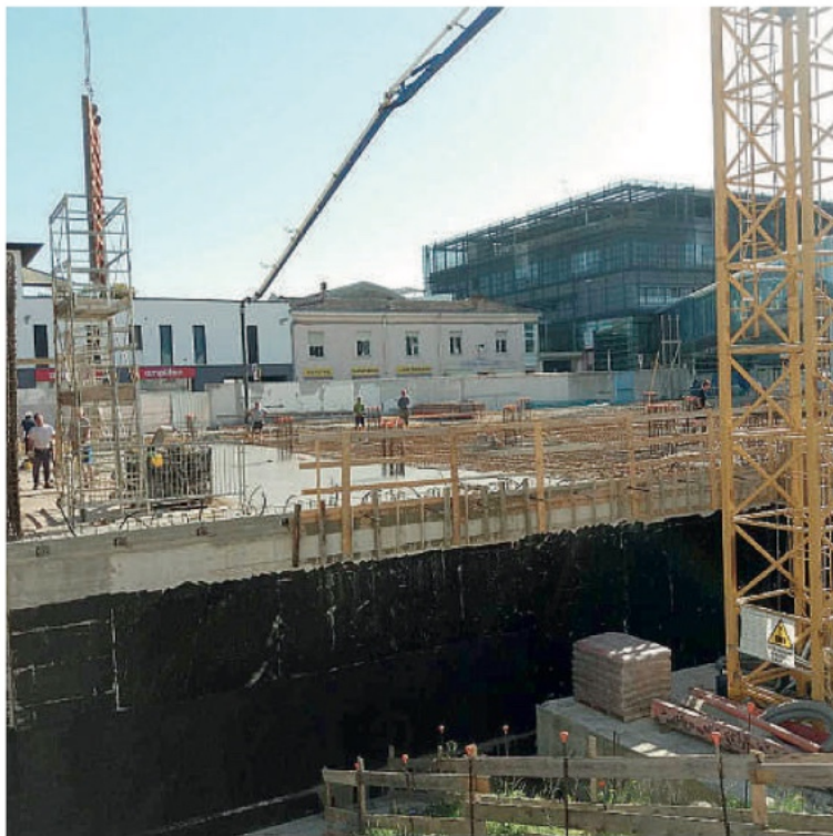
Terminato il piano interrato della struttura FOTO MENEGHELLI
