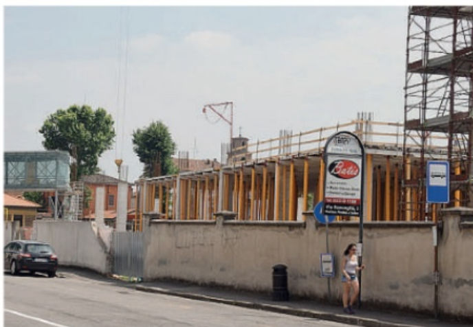
Il cantiere della nuova ala dell'ospedale di Fiorenzuola
