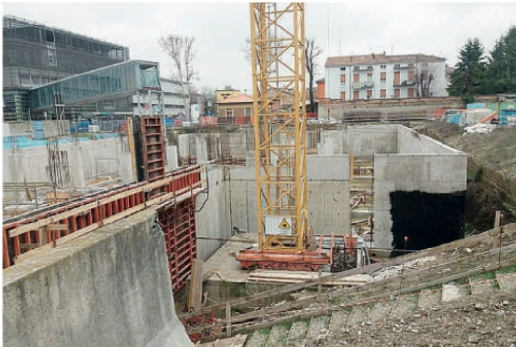
Il cantiere del blocco B dell'ospedale che ospiterà il polo riabilitativo
