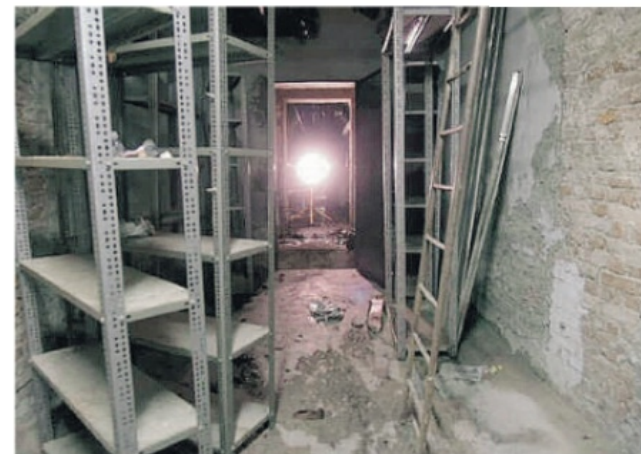
Alcuni ambienti sono stati già svuotati dal materiale abbandonato
