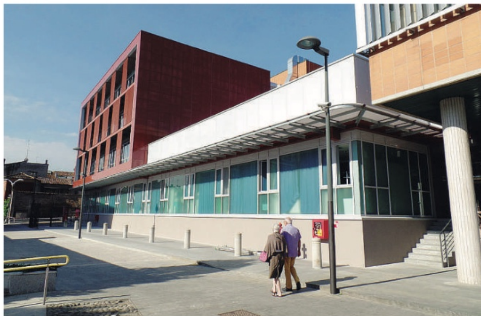
L'esterno del Polichirurgico dove l'altro pomeriggio è avvenuto un ennesimo furto
