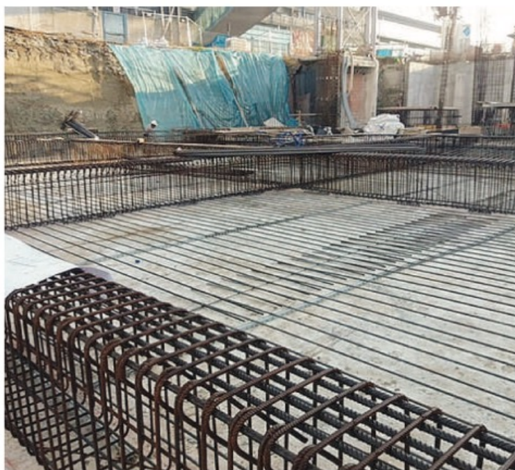
Il cantiere dell'ospedale. Domani incontro sul futuro della sanità FOTO MENEGHELLI
